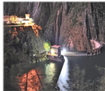
大甲溪發電廠
