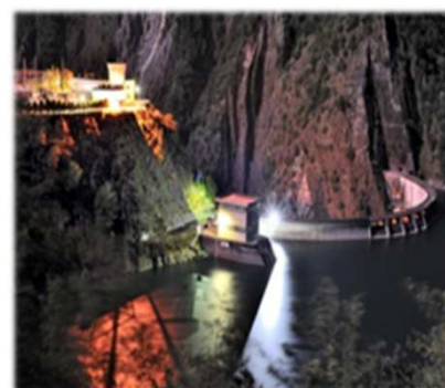
大甲溪發電廠
