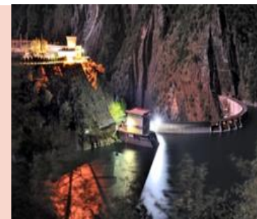
大甲溪發電廠
