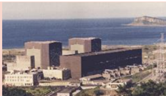
第二核能發電廠
