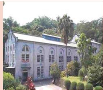
高屏發電廠(竹門機組)
